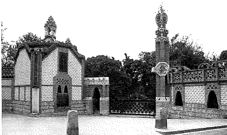
Figura 27: Pabellones de la Finca Güell: Casa del Guardia, puerta y Caballerizas.
