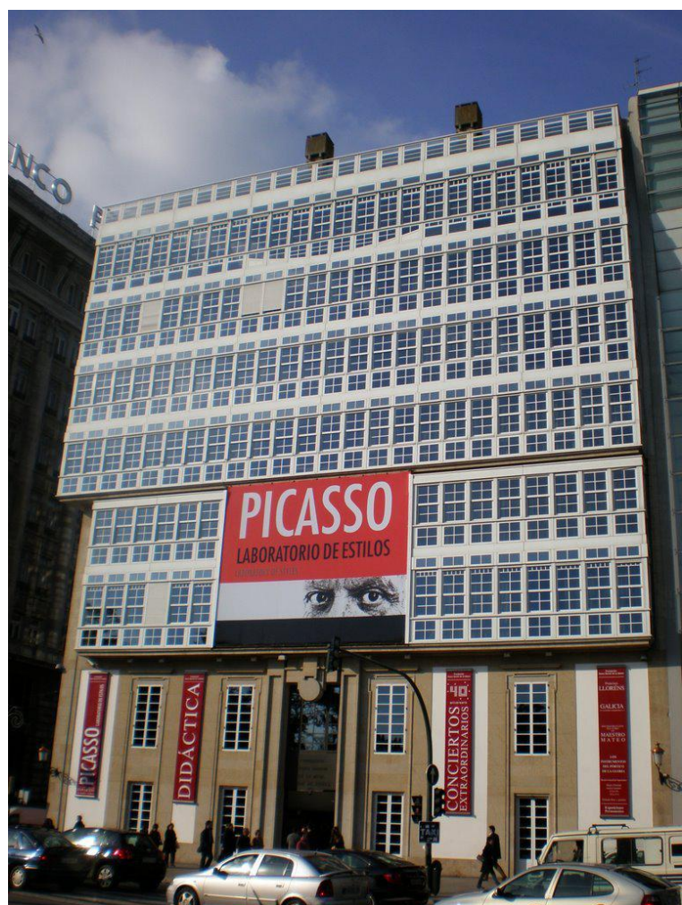
Sede de la Fundación Barrié en A Coruña
