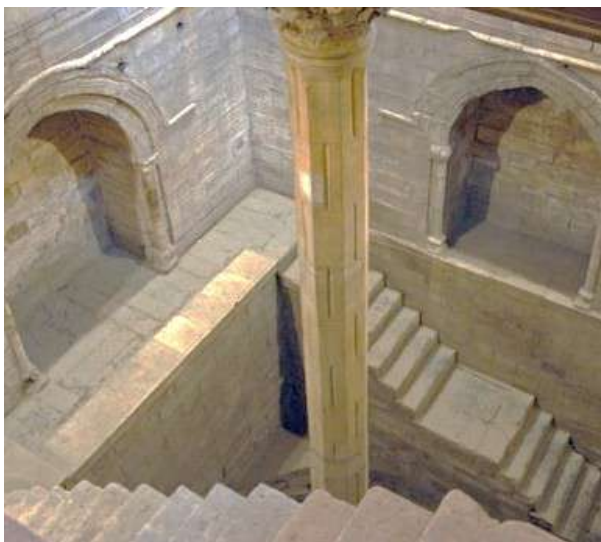
Fig. 27. Nilómetro, instrumento egipcio que servía para medir las crecidas del río Nilo
