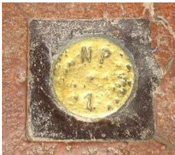
Fig. 83. Punto de nivelación del Ayuntamiento de Alicante.
