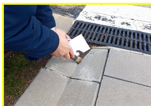
Fig. 4. Primer método: en el material de cunetas.
