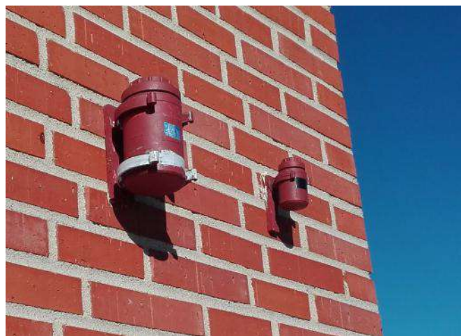
Fig. 2 Cámaras de PVC, de 70 mm y 40 mm
